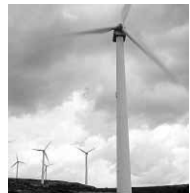
Los aerogeneradores, para Alstom
